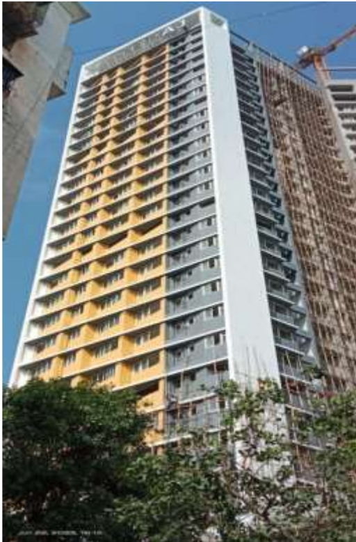
Tenant Building – Ave Maria
